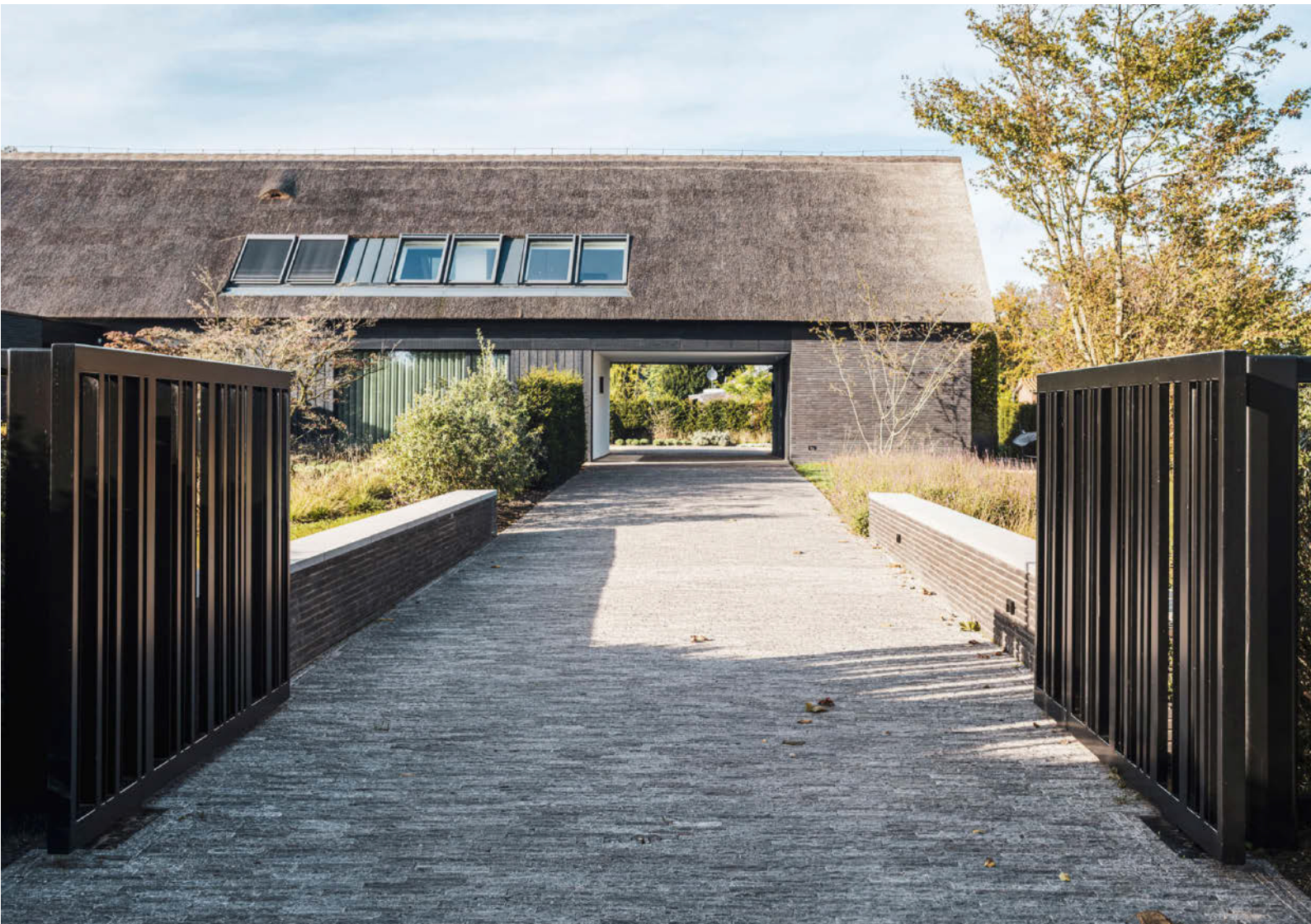
Leverancier schuifpui: Solarlux Gevel facades (exterieur): Sunshield Aluminium kozijnen & schuifpui: Busscher Serrebouw
